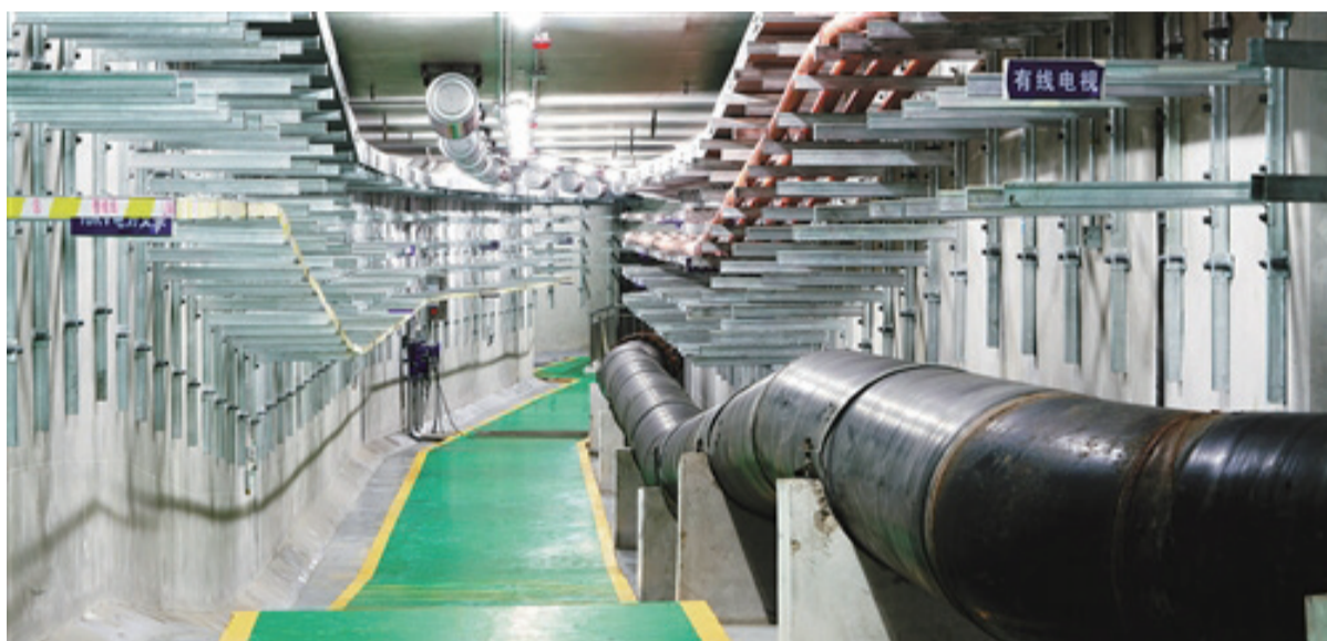
海口市地下綜合管廊內部。
