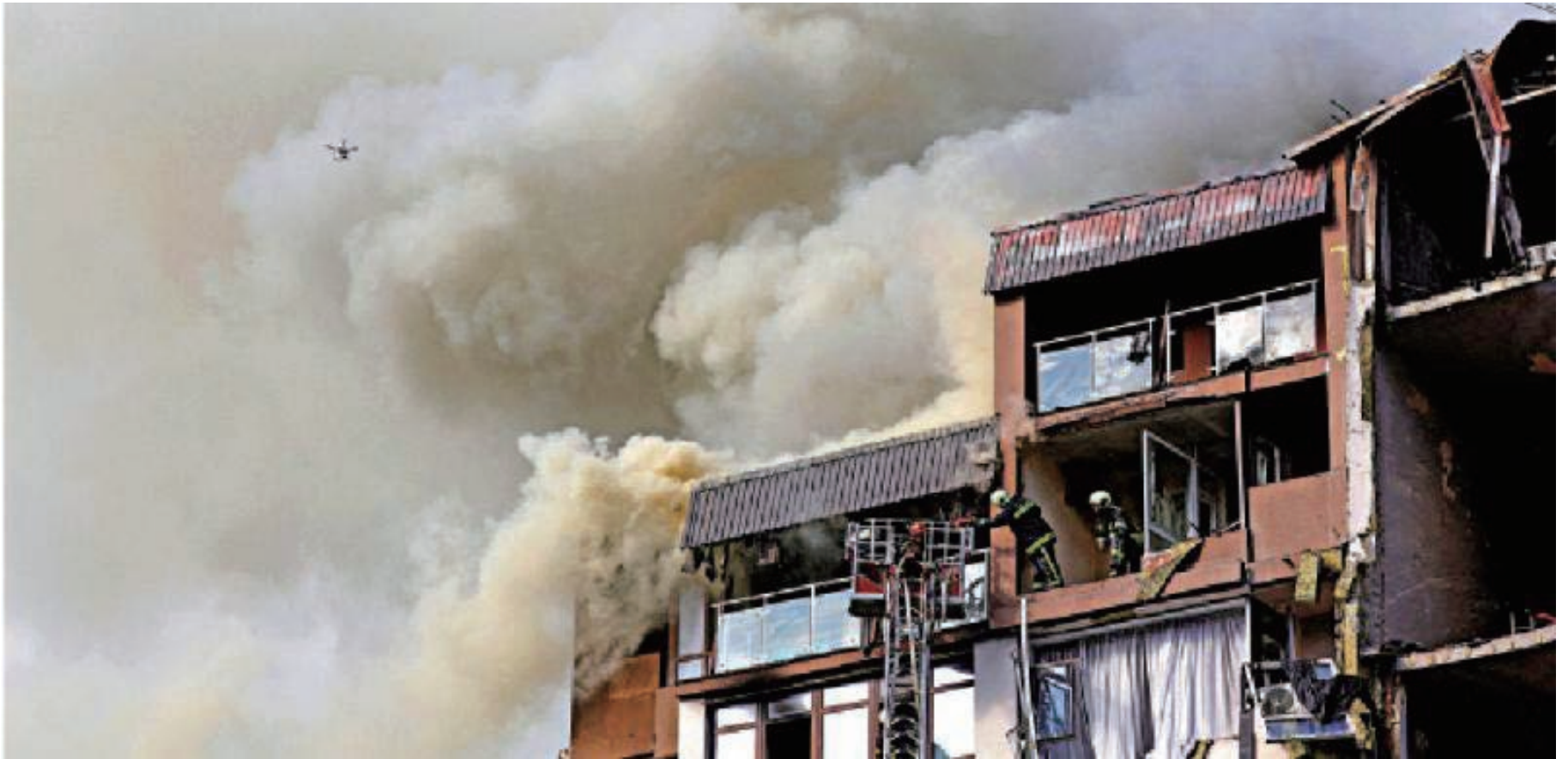
烏克蘭首都基輔 26 日被襲，當地一棟居民樓損毀後冒出濃烟。/ 路透社
