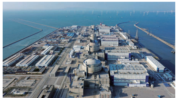
福清核電機組外景
