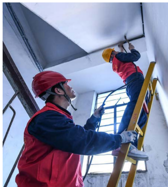
志愿者在楼道内安装线路。新华社记者徐昱摄
