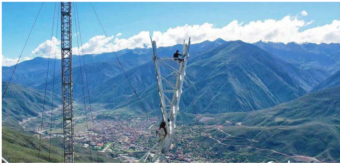
在四川省甘孜州巴塘县至澜沧江 500 千伏线路施工现场，电力工人正在高空进行铁塔组立作业。刘洋摄
