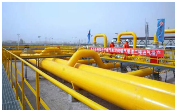
双台子储气库双向输气管道工程投产。受访者供图
