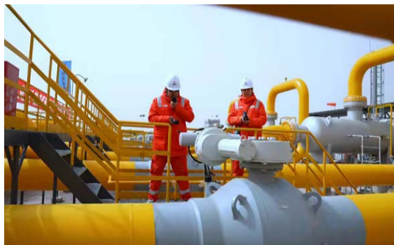
双台子储气库双向输气管道工程投产。受访者供图
