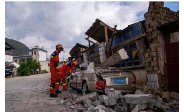
5月3日，应急救援人员在云南省保山市隆阳区瓦窑镇排查受损的房屋和车辆。
