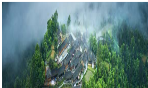
图为矮寨·十八洞·德夯大峡谷景区 \ 资料图
