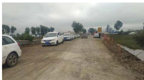
经过三天三夜持续抢修，G229饶盖公路五常至尚志段全线抢通。黑龙江省交通运输厅供图
