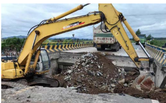
防汛抢险人员修补破损路面。黑龙江省交通运输厅供图
