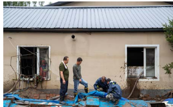
8月6日，在大海林林业局有限公司自来水供应站，工作人员在设置管线排水。
