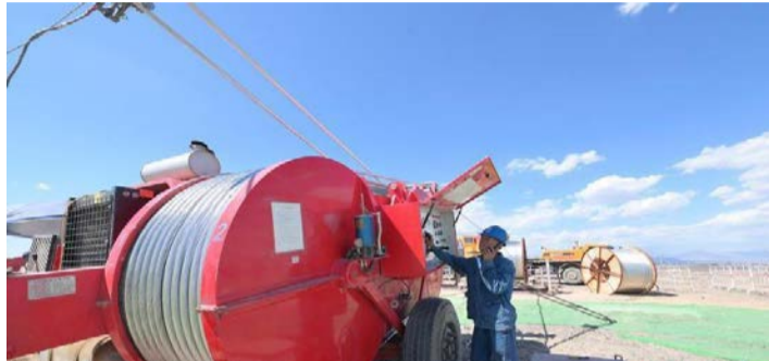
8月10日，吐鲁番鄯善——合盛多晶硅2号变三回220千伏线路跨越柯哈牵线作业现场，电力工人开展作业。刘栋 摄
