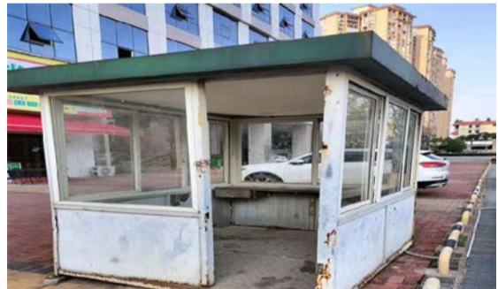
图为现场情况
