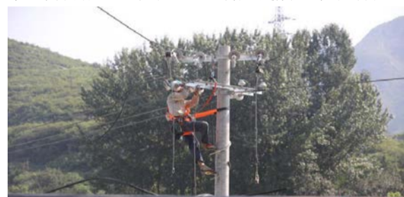
国网北京房山供电公司工作人员在灾后重建现场建设线路。张颖 摄
