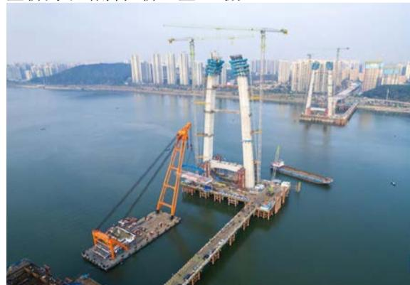
这是12月12日在长沙兴联路大通道项目拍摄的双塔斜拉桥首段主梁架设施工现场（无人机照片）。
