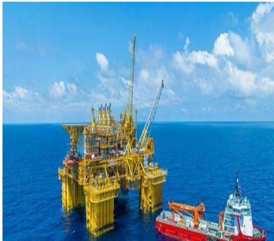
“深海一号”能源站是全球首座10万吨级深水半潜式生产储油平台。中国海油供图 袁琛 摄
