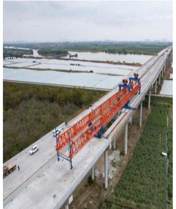
南中高速TJ02标段贯通。中铁大桥局 供图
