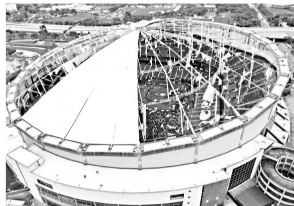
飓风“米尔顿”掀飞被用作临时避难所的纯品康纳球场屋顶。法新社
